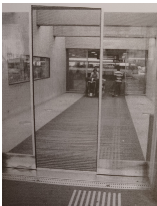
Abbildung 2: Beispiel einer Schmutzschleuse im Flughafen Zürich
