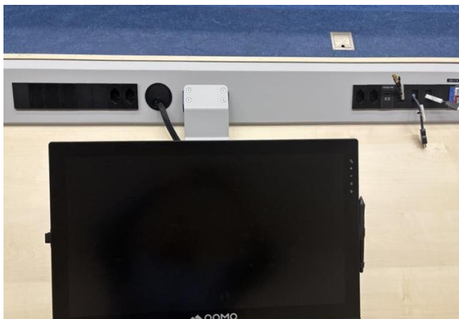
Detail Display interaktiv (Kabeldurchführung)
